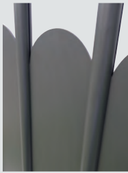
Tôle intégrée entre deux barreaux
